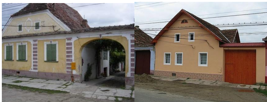
Figura 5: Nr 352 Laslea sat. 2003 (l) și 2009. Acestea par a fi case diferite, sau o construcție complet nouă. În fapt, este o reabilitare extensivă și un proiect retrofit. (Autor)
